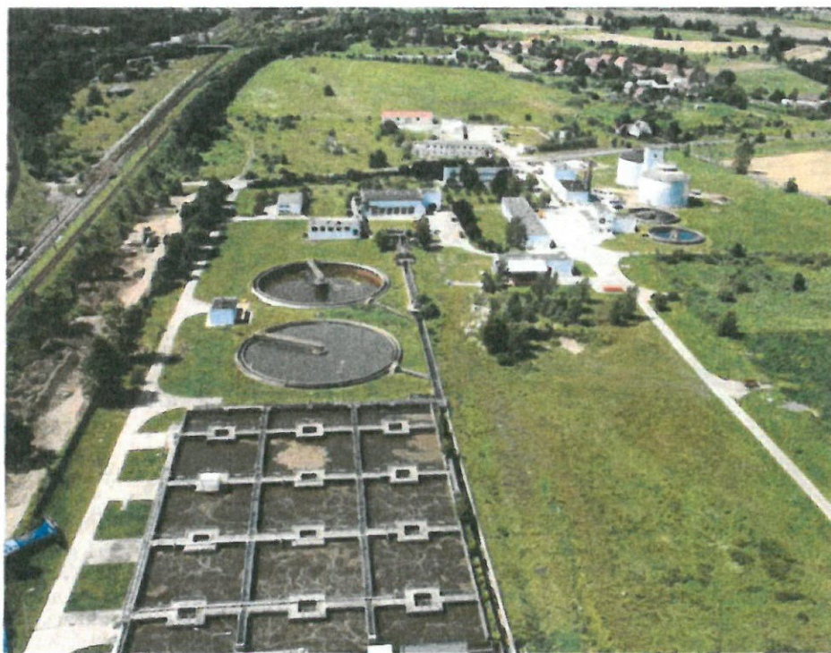
► W Zakładzie Oczyszczania Ścieków przy ulicy Spokojnej w Legnicy, do czerwca 2015 roku, zostanie wybudowana suszarnia osadów ściekowych. Zgodnie z unijną dyrektywą, już w 2015 roku nie będzie można składować powstających osadów. Zastąpi je utylizacja
